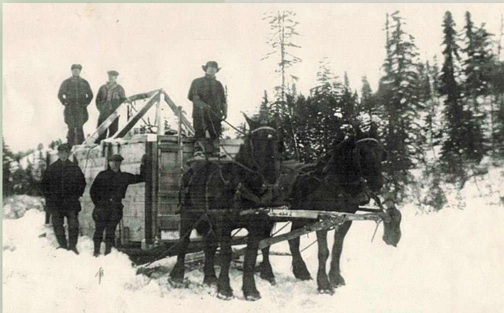
Moi, en bas à l'avant, avec le réservoir servant à glacer les chemins de charriage. Chicoutimi 1941.
