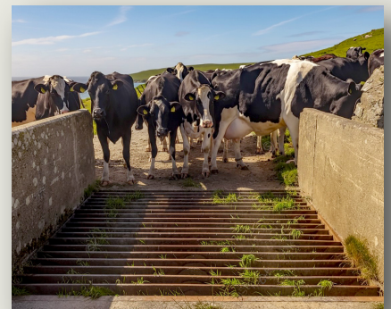
Barrière de type grillage au sol.
