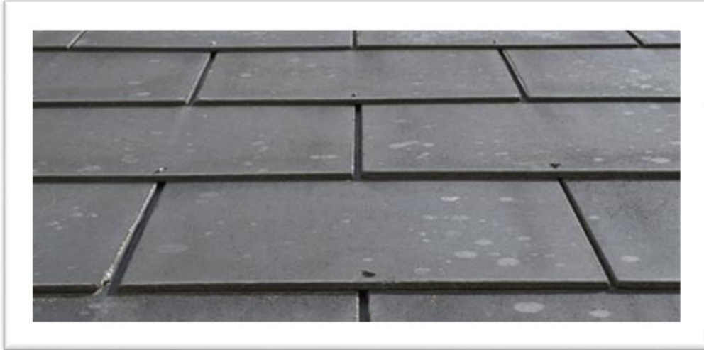
Figure 50 : Assemblage de tuile d'ardoise à éviter pour l'immense majorité des maisons patrimoniales de Ville de Bécancour. Il convient surtout aux bâtiments en milieu urbain. Photo de source inconnue.
