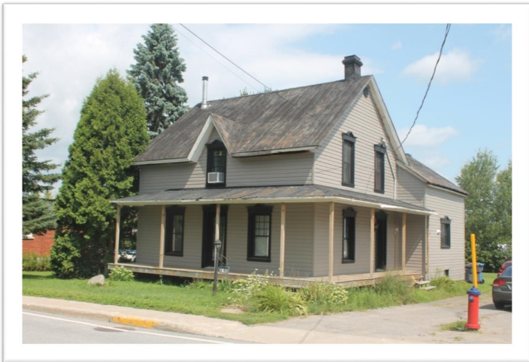
Figure 190: Maison sise à Ville de Bécancour. La couleur des murs est intéressante, mais le noir des encadrements d'ouvertures ne permet pas de bien observer les détails architecturaux. De plus, s'ils sont dans l'ombre, on n'y voit presque rien. Ainsi, une couleur plus pâle aurait dû être retenue. Crédit photo: Patrimoine Bécancour.
