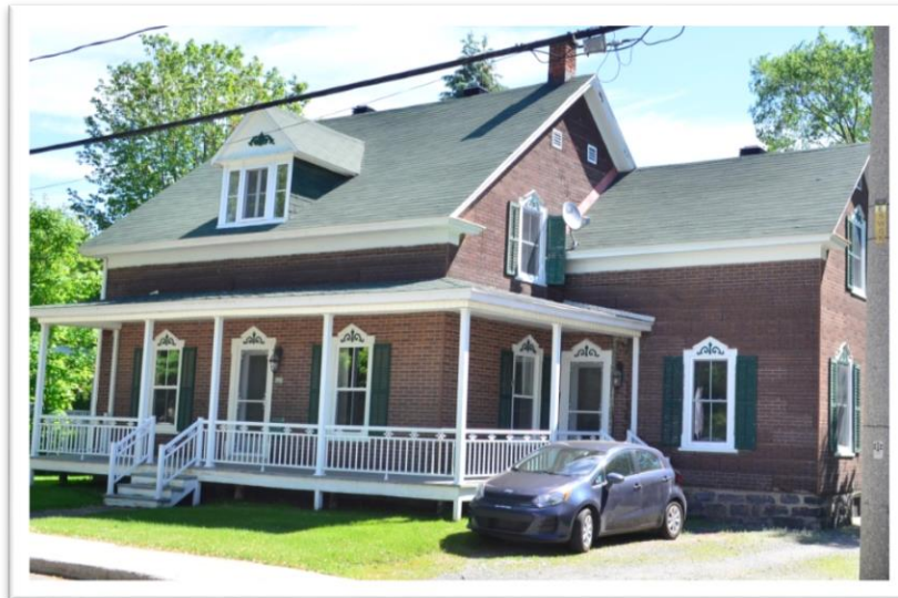
Figure 23: Ajout tout à fait conforme. Réplique en plus petite du carré principal. Même pente que le carré principal, ainsi qu'une harmonisation des revêtements, des ouvertures et des encadrements. Maison sise au 2535, Nicolas-Perrot, dans le secteur Bécancour. Crédit photo: Patrimoine Bécancour.
