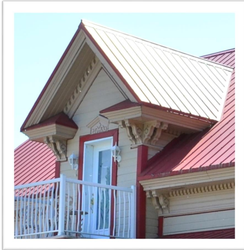
Figure 90: Type de lucarne pendante, assez rare dans la MRC de Bécancour. Maison sise au 2730, Nicolas-Perrot, à Bécancour. Crédit photo: Patrimoine Bécancour.
