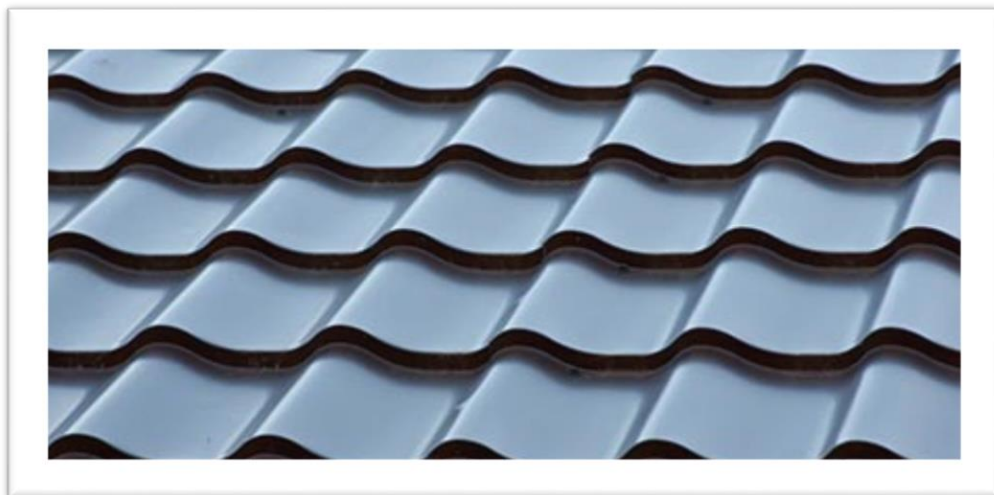
Figure 53 : Ce profil ondulé de tuile métallique est à proscrire. Il ne présente aucun intérêt patrimonial. Toutefois, comme vu plus haut, certaines autres formes peuvent être acceptables.
