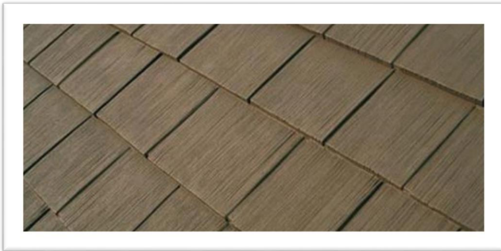
Figure 47: Tuile d'élastomère imitant le bardeau de bois. Je n'ai jamais vu personnellement l'apparence de ce genre de matériau sur un toit. Il semble que son apparence n'est pas vraiment naturelle. Certains prétendent qu'il présente des risques de décoloration avec le temps. Photo de source inconnue.
