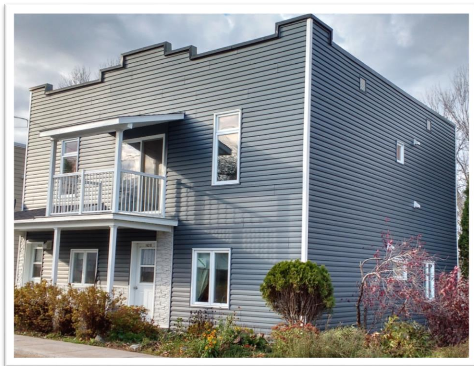
Figure 21: Façade postiche après des rénovations majeures. Maison sise au 14210-14220, boul. Bécancour, à Sainte-Angèle. Crédit photo: Patrimoine Bécancour.
