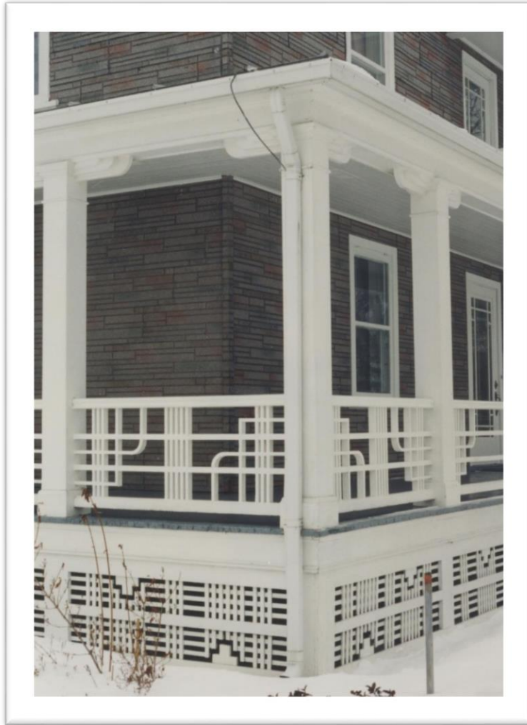
Figure 172: Photo montrant un treillis artisanal aux lignes fort recherchées, s'harmonisant parfaitement bien avec les autres composantes de la galerie couverte: aisseliers, balustres et colonnes. Localité de Deschambault. Photo de Jean-Pierre Chartier.
