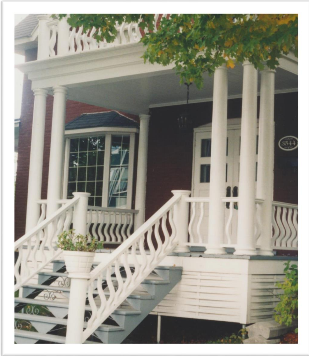
Figure 165: Planchettes de 1 3/4 de pouce de largeur et 1/2 d'épaisseur serpentant entre des composantes verticales, rappelant la grosse vannerie, technique utilisée dans la fabrication des paniers. Notez au passage le magnifique triplet de colonnes rondes à chacun des deux coins extérieurs de la galerie, ainsi que les beaux balustres galbés des garde-corps. Ville de Lac-Mégantic. Photo de Jean-Pierre Chartier.
