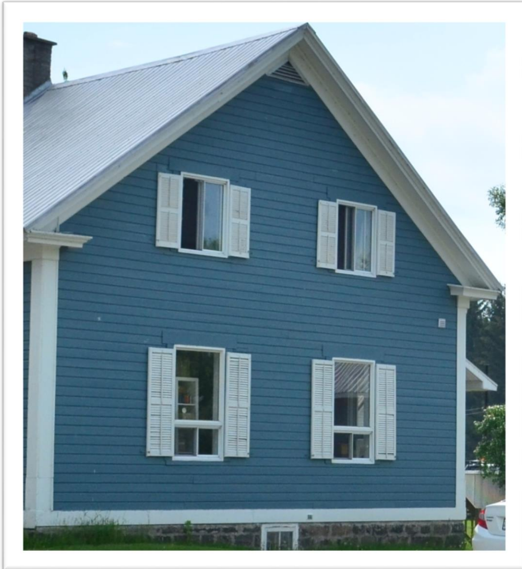
Figure 80: Planche basale au bas du mur, planche cornière aux coins du carré principal et planches de frise sous l'avant-toit. Il faut conserver ces atouts qui permettent de bien encadrer chacun des murs de la maison. Crédit photo: Patrimoine Bécancour.
