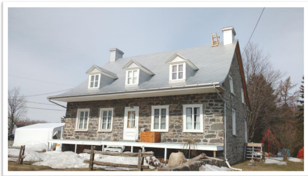
Figure 2: Bel exemple d'une maison à versants galbés avec un plan rectangulaire. Les ouvertures présentent une belle symétrie. Trois lucarnes percent le versant avant. Maison sise à Ville de Bécancour. Crédit photo: Patrimoine Bécancour.
