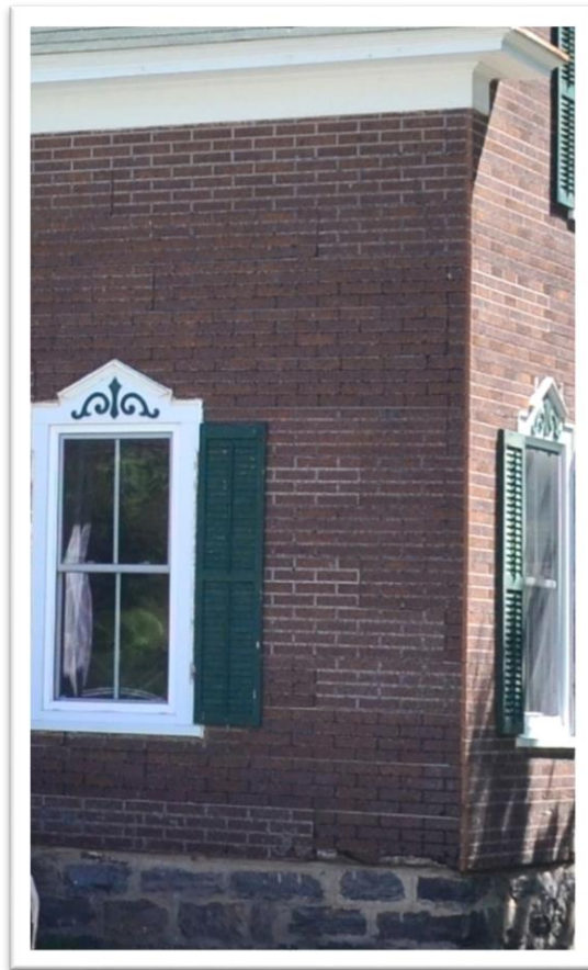
Figure 64: Revêtement de papier brique. Maison sise au 2535, boul. Nicolas-Perrot, à Bécancour. Crédit photo: Patrimoine Bécancour.
