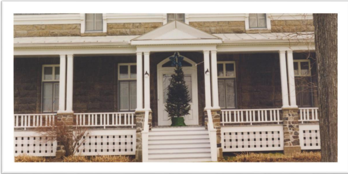
Figure 173: Treillis tout à fait intéressant, composé de lattes verticales et horizontales regroupées par trois. L'encadrement nécessaire du treillis est ici présent. Presbytère de Saint-Hilaire dans la vallée du Richelieu. Photo de Jean-Pierre Chartier.
