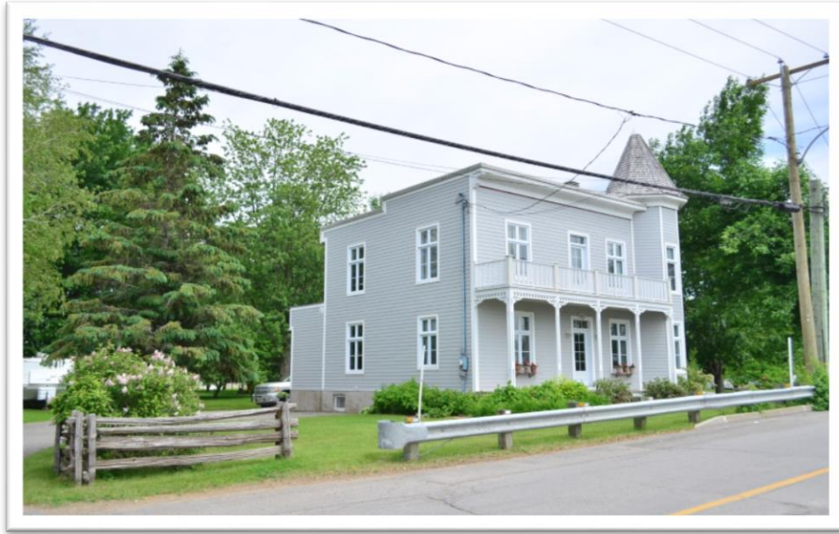
Figure 20: Maison à façade postiche, avec toit à très faible inclinaison. La corniche est rectiligne, mais possède une planche à la rencontre du haut du mur et de la corniche. À l'angle de ces derniers, moulures et modillons sont heureusement sauvegardés, même après les rénovations majeures. Remarquez le sommet des murs latéraux en forme de marches d'escalier. Une belle tourelle lui donne un goût victorien. Maison sise au 3425, rue Nicolas-Perrot, à Bécancour. Crédit photo: Patrimoine Bécancour.
