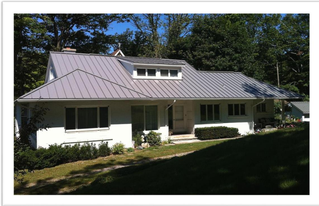
Figure 58: Toiture de la compagnie Idéal Revêtement. La pose faite, le tout ressemble beaucoup à la tôle traditionnelle dite pincée. Le choix à retenir est selon moi le profilé susmentionné, avec les deux couleurs
