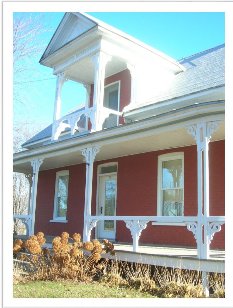
Figure 140: Cas très intéressant présentant une logique ou une harmonie de l'ensemble. Des aisseliers absolument identiques se présentent autant sous la poutre horizontale soutenue par des colonnes jumelles, et autant sous la main courante des garde-corps de la galerie couverte et du balcon couvert à l'étage. Maison sise quelque part en Mauricie. Nous avons observé à plusieurs reprises ce genre de balustrade à Ville de Bécancour. Photo de Jean-Pierre Chartier.
