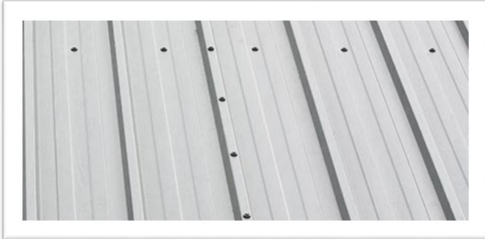
Figure 45: Photo illustrant de fausses baguettes trop rapprochées pour être un matériau intéressant. De plus, les têtes de vis apparentes présentent un handicap.
