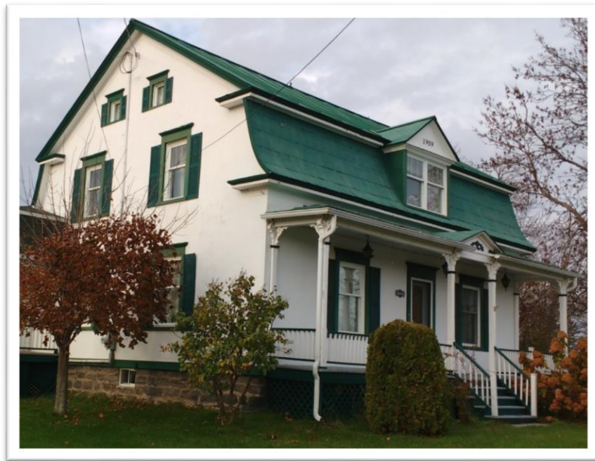
Figure 16: Maison à toit brisé, dit à la Mansart. Maison sise au 11 600, boul. Bécancour, à Sainte-Angèle. Crédit photo: Patrimoine Bécancour.
