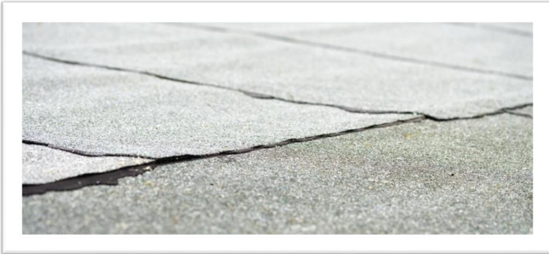
Figure 52 : Membrane d'élastomère convenant pour les toits plats ou légèrement en pente comme les maisons à façade postiche. Photo de source inconnue.
