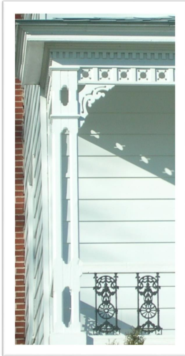
Figure 188: Les dentelures se fixent presque toujours, ou presque, à la jonction de l'avant-toit de la galerie et de la poutre horizontale (ou entablement). Sous cet avant-toit on peut voir une moulure traditionnelle adoucissant les angles. À l'angle de la plate-forme, remarquez la colonne formée de 3 pièces verticales et le lambrequin courant sous la poutre horizontale muni de ses équerres (aisseliers).
