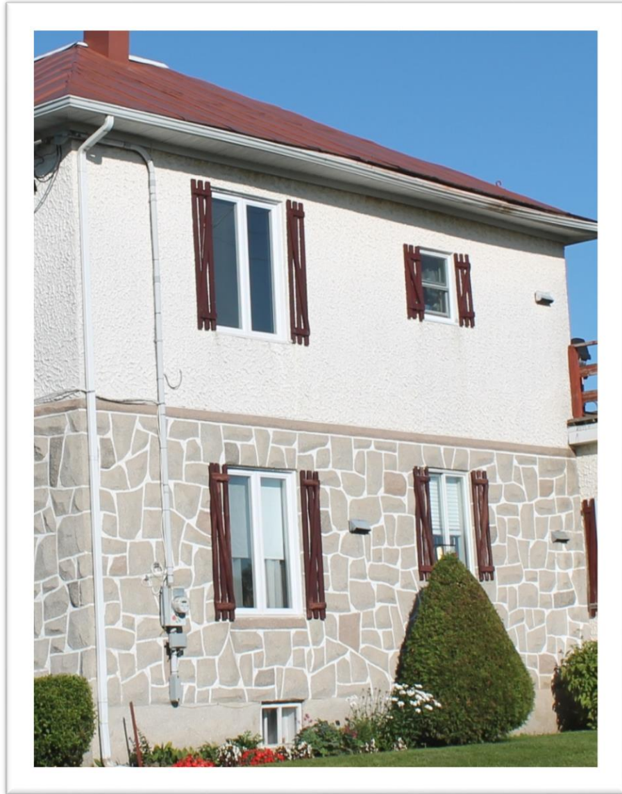
Figure 69: Imitation de pierre taillée au premier niveau et du stuc à l'étage supérieur. Maison sise au 11 255, Chemin du Saint-Laurent, à Précieux-Sang. Crédit photo: Patrimoine Bécancour.
