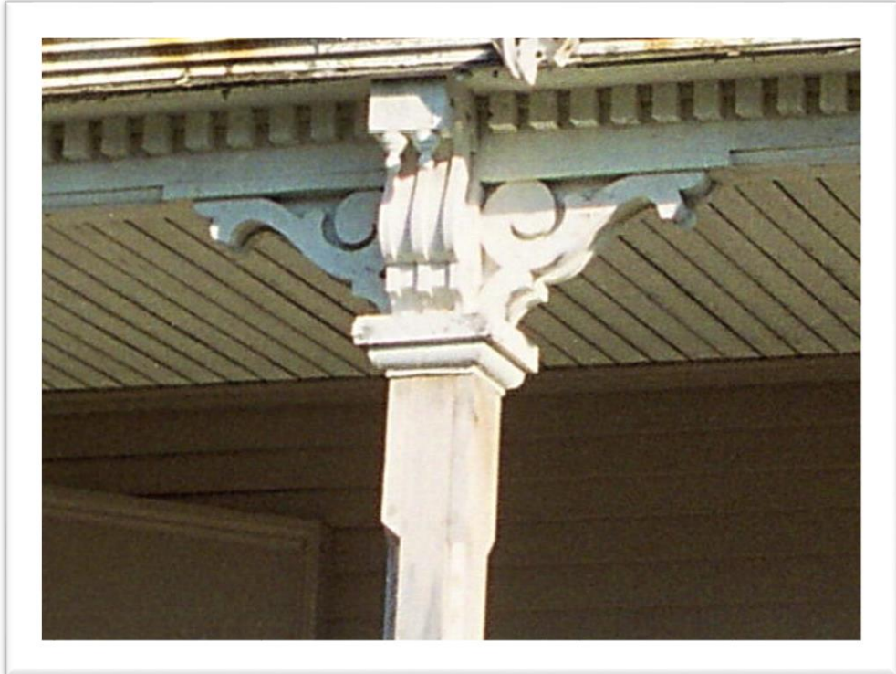
Figure 189: Remarquez la dentelure sous l'avant-toit, les consoles réunissant le sommet de la colonne et la poutre horizontale.
