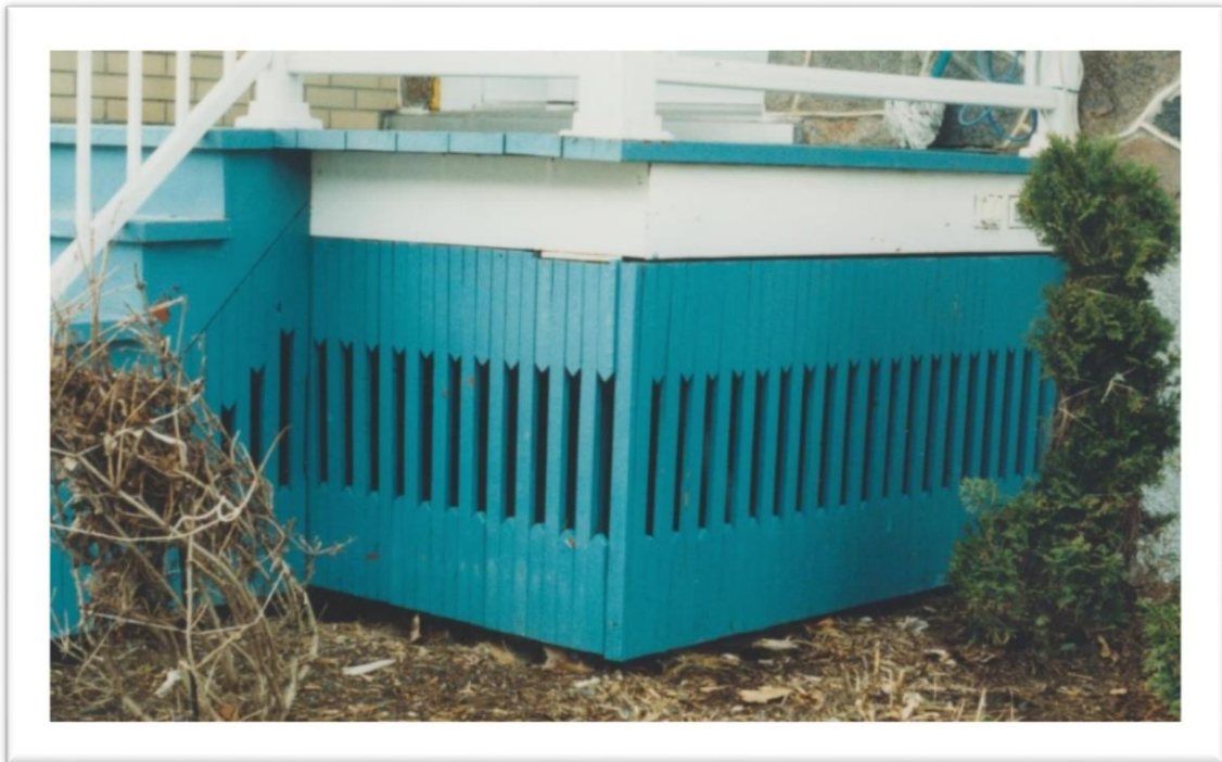
Figure 171: Alternance de planchettes pleine longueur avec d'autres plus courtes, et dont les extrémités se terminent en pointe. L'assemblage forme un design intéressant, et permet une bonne ventilation du dessous de la galerie. Toutes les planchettes ont une largeur de 1 ½ pouce et une épaisseur de ¾. Pour offrir un effet similaire, on pourrait tout aussi bien tailler les extrémités en demi-rond. Il aurait été plus esthétique que la jupe soit plus en retrait, environ ¾ ou 1 pouce sous la solive du plancher de la galerie. Photo prise à Saint-François-de-la-Rivière-du-Sud, près de Montmagny, par Jean-Pierre Chartier.
