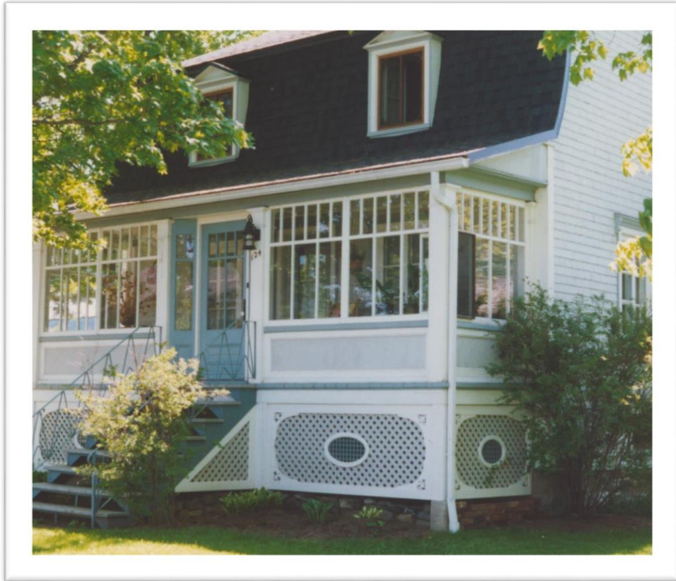
Figure 176: Très jolie jupe d'une demeure sise à Cap-Saint-Ignace (Bas-Saint-Laurent). L'assemblage des éléments de cette jupe avec ses lignes courbes permet d'alléger l'ensemble, même si la forte dénivellation impose une très grande surface de jupe. Ici, un treillis du type Intimité est utilisé. Photo de Jean-Pierre Chartier.
