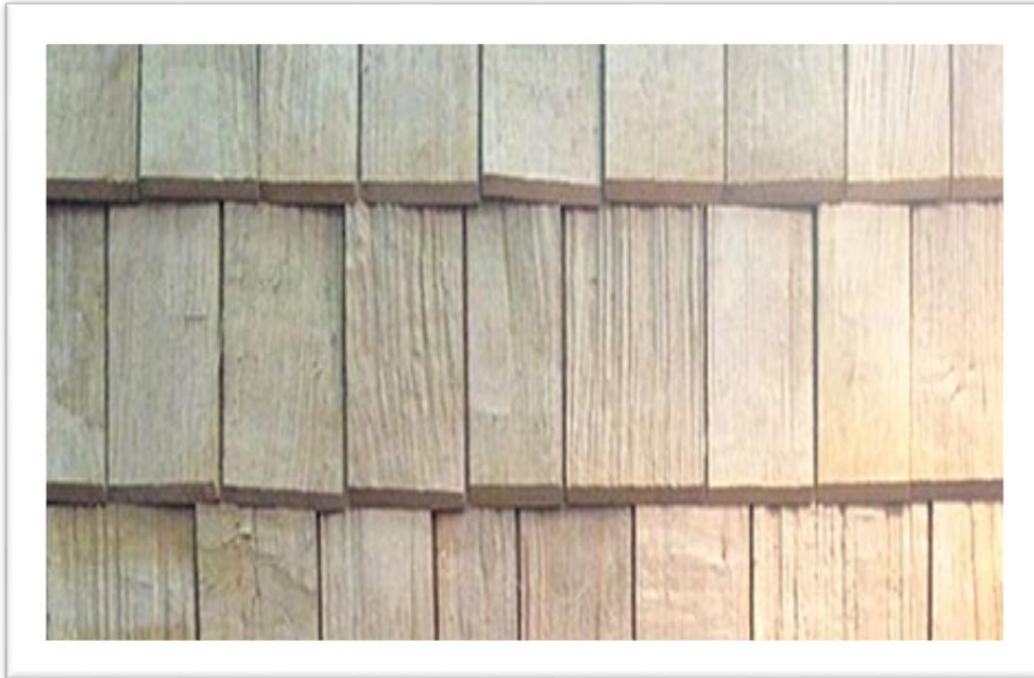
Figure 39: Bardeau de mélèze. Dispendieux, certes, mais il offre un aspect rustique très intéressant. Matériau reconnu pour sa durabilité. Photo de source inconnue.
