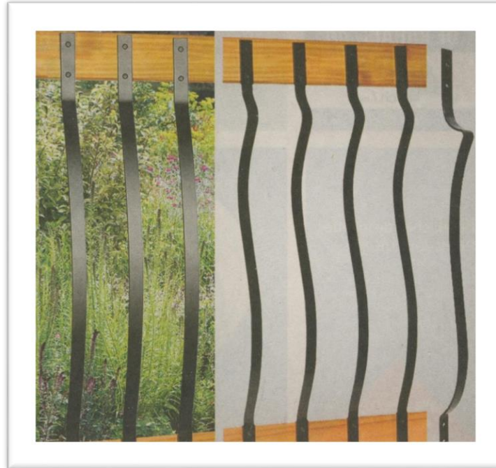
Figure 131: Languettes métalliques dont les extrémités sont fixées à des 2 X 4. À éviter.
