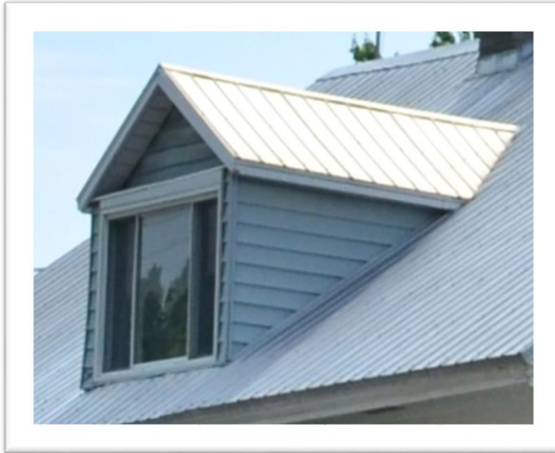
Figure 88: Grosse lucarne unique à deux versants droits. La lucarne à deux versants droits, est l'un des deux types les plus répandus sur le territoire de Ville de Bécancour. Maison sise au 1240, Nicolas-Perrot, à Bécancour. Crédit photo: Patrimoine Bécancour.
