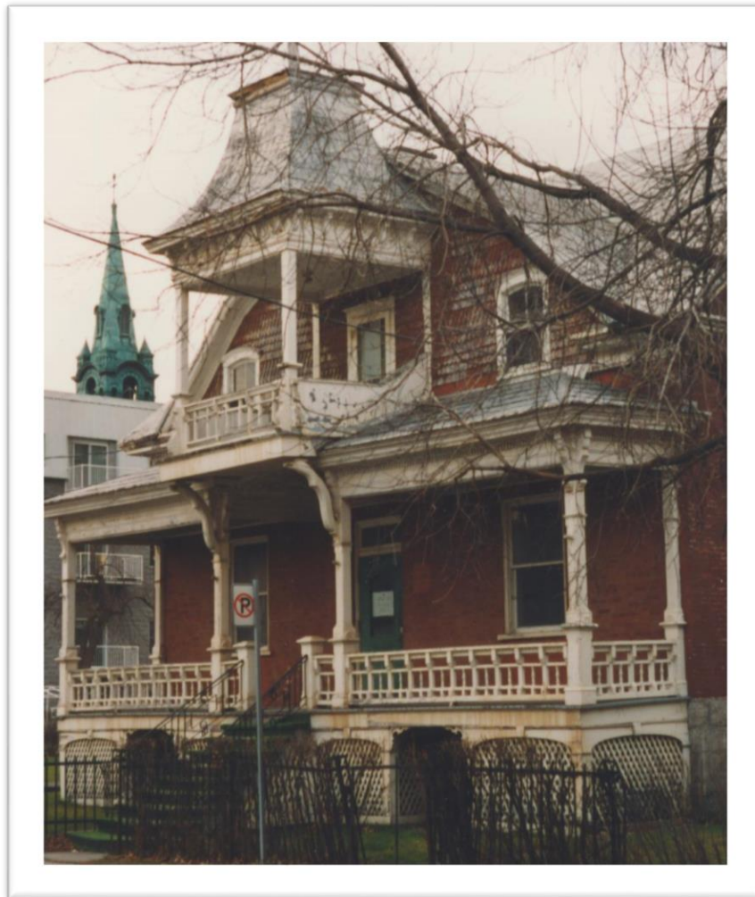
Figure 175: Jupe d'une demeure du type victorien, toujours d'un grand intérêt. Elle comporte un arc surbaissé muni de sa clé de voûte, dont les rives sont moulurées. Un treillis aux lattes assemblées obliquement, à angle aigu d'environ 70 degrés, ferme l'espace sous la galerie. Vallée du Richelieu. Photo de Jean-Pierre Chartier.
