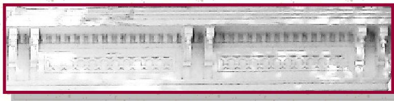
Corniche du toit, entablement ionique et frise
